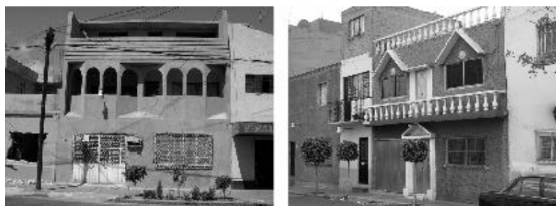
Figura 4. La gente pobre intenta sin recursos y sin arquitectos, construir obras que se parezcan en algo a las fotos de las revistas de moda. Por eso el mundo en desarrollo está lleno de ejemplos 'posmodernos-renacentistas' que tienden más al kitch que al diseño arquitectónico, pero que de una u otra manera involucra a sus autoconstructores' en este mundo de la imagen de 'lo bien'.
